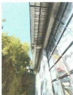
Foto 7: Canales y bajadas de agua
