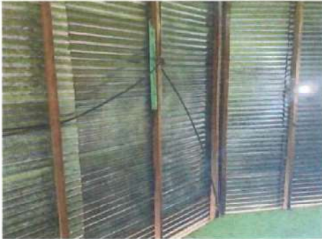
Foto 1: Cubierta de lámina
