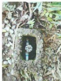
Foto 10: Reparación de drenaje y agua potable
