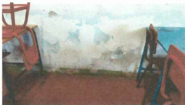
Foto 8: Pintura interior y exterior de muros
