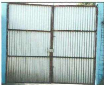
Foto 9: Mantenimiento de portón
